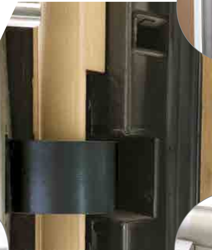
Dettaglio cerniera a scomparsa Hidden hinges detail
